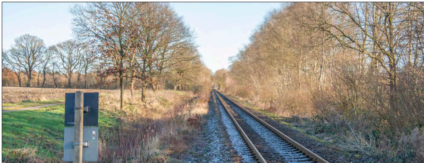
Teilfläche 1 - Südliche Plangrenze mit Graben und Bahnstrecke in östliche Richtung
