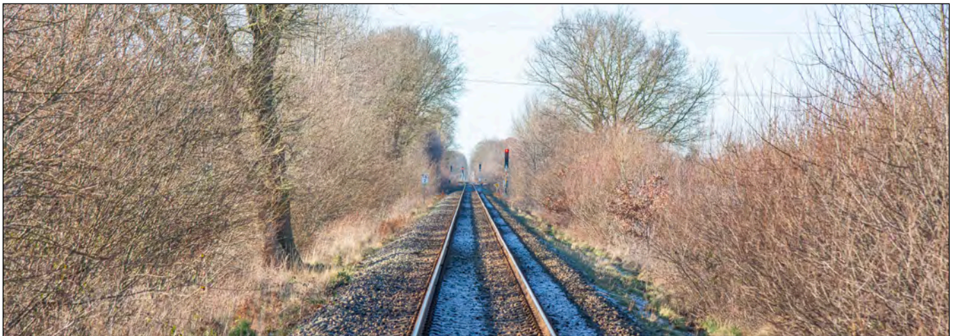
Teilfläche 2 - Bahnstrecke in westliche Richtung zwischen den beiden westlichen Plangebieten
